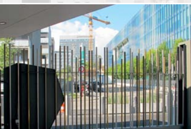
PORTAIL ET CLÔTURE
