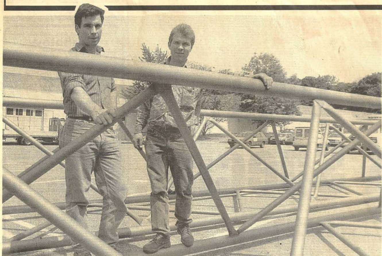
Eric (à gauche) et Jean-Pierre Magnin, de l'entreprise de construction Alfer Magnin S.A., sur l'un des six éléments métalliques qui formeront bientôt l'écran géant de Cinélaac. (APPS)
